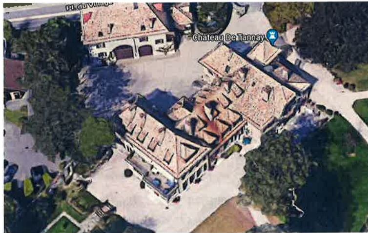
Figure 9 : Vue aérienne - Toitures et installations solaires (source : google.ch)
