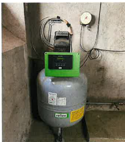
Figure 6 : Système de maintien en pression
